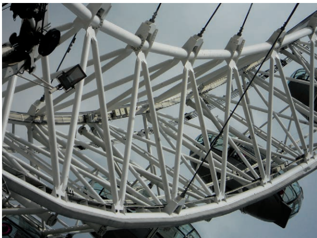
Čelični okvir trokutaste rešetkaste konstrukcije
