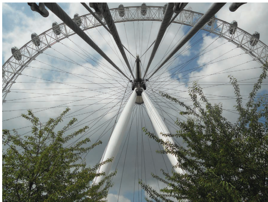
A-okvir položen je između osovine i stopa stupa
