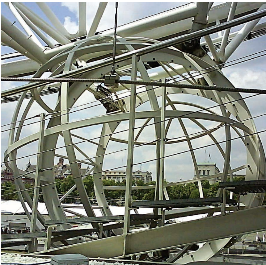
Čelična konstrukcija kabine
